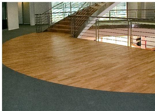
HINWEIS: Beachten Sie auch unsere Hinweise für die fachgerechte Belagsverlegung auf dem AGB Hohlraumboden. Prüfen Sie die Restfeuchte vor dem Verlegen der Beläge. Dank der *konstanten Dicke der Tragschicht aus Calciumsulfat-Fliessestrich CAF* ist dies problemlos möglich. Wir empfehlen, unbedingt mit dem Kleberlieferanten ein auf die jeweilige Charakteristik des Belags abgestimmtes Verlegesystem auszuarbeiten.
